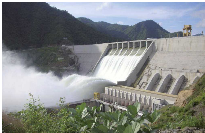
Usine hydroélectrique en fonction (© AF-Consult, Switzerland)
