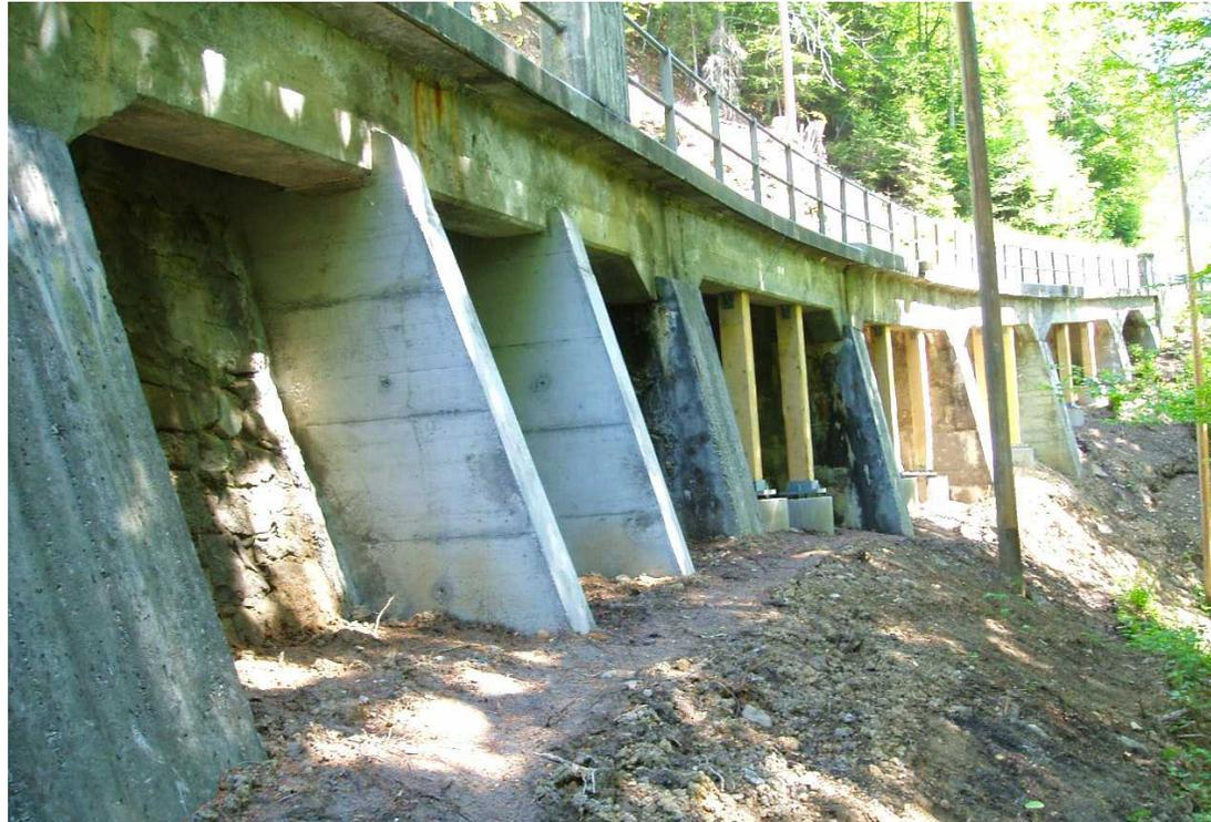
L'estacade sous les Caudreys se situe sur la route cantonale RC 705a reliant Vionnaz à Château-d'Oex. L'ouvrage se trouve sur la commune d'Ormont-Dessous. L'estacade, d'une longueur de 54.70 m, est constituée de dalles avec des sommiers de bord reposant sur des contreforts en béton.
