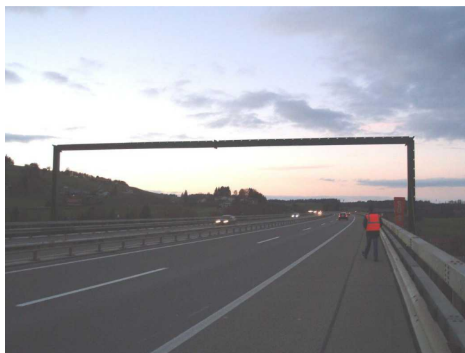
Portique sur le viaduc de la Gruyère
