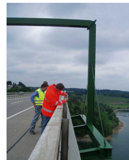
Attache du portique sur le viaduc de la Gruyère
