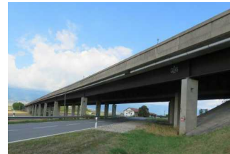
N01 - Viaducs du Chêne Droite+Gauche (VD)
