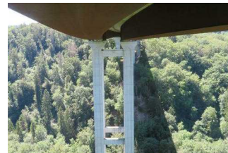
N01 - Viaducs des Vaux Droite+Gauche (VD)
