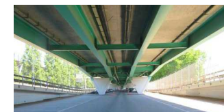
N01a - Viaduc voie centrale (GE)
