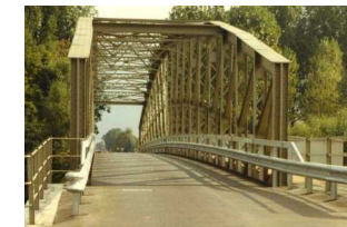
Après remise en état
